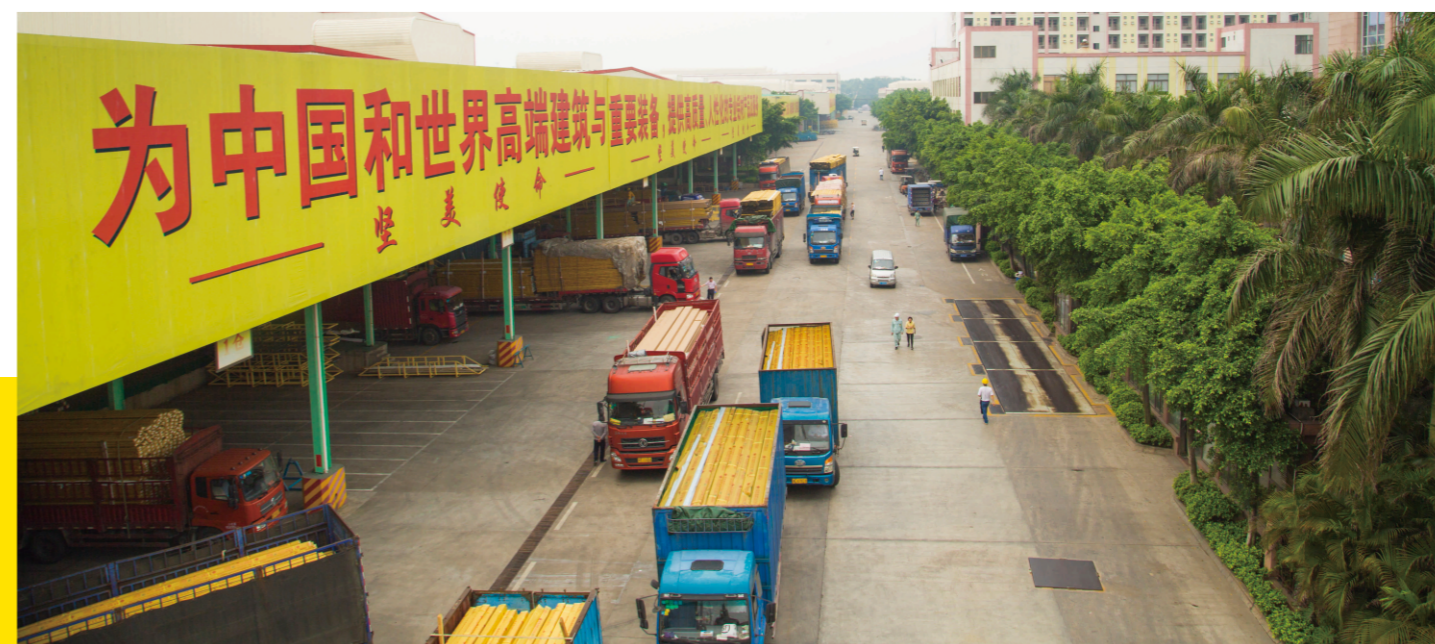
狮山厂区发货大道 Intelligent Warehouse
